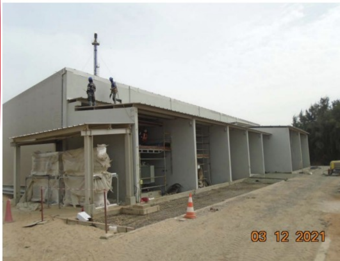
Travaux de fin de Bardage de la Sous Station P0
