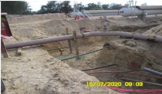
Tranchée pour câbles électriques 6,6 kv
