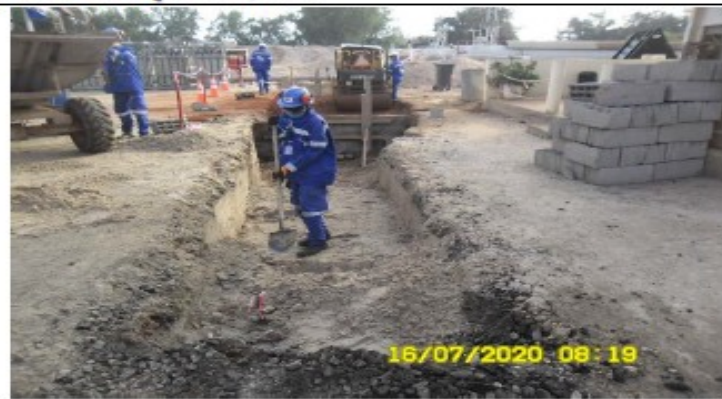
Tranchée pour câbles électriques 6,6 kv
