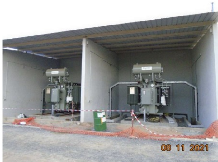
Installation des Transformateurs terminée(Vue Sud Est P0)
