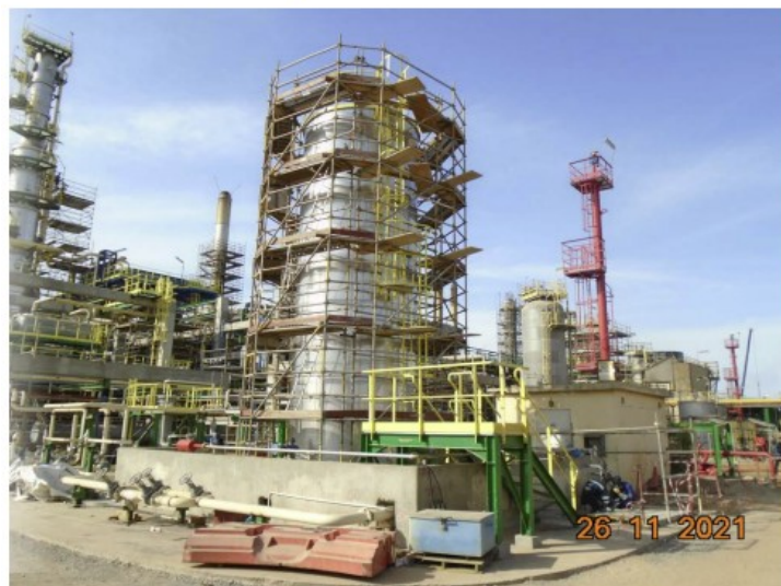
Travaux de Calorifuge sur le ballon D-362
