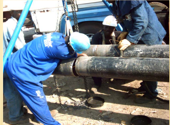
PREPARATION DE SOUDURE
