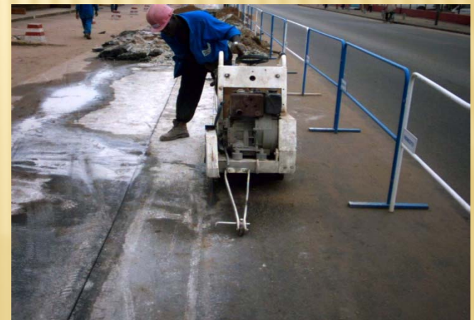
DECOUPAGE DU BITUME
